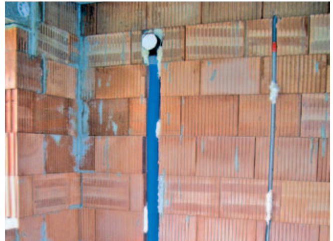
Befestigung des Luftverteilschlauches und der Saugnische im Mauerstutz mit Montageschaum
