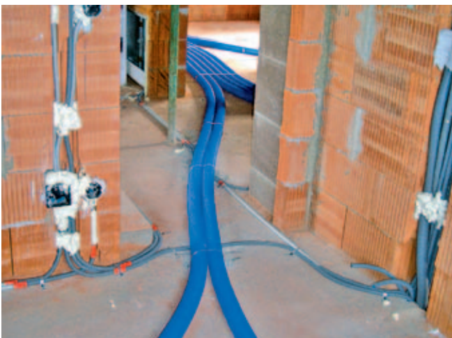
Ein weiteres Verlegebeispiel im Fußbodenaufbau
